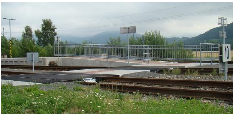
Přístup přes koleje na nástupiště
