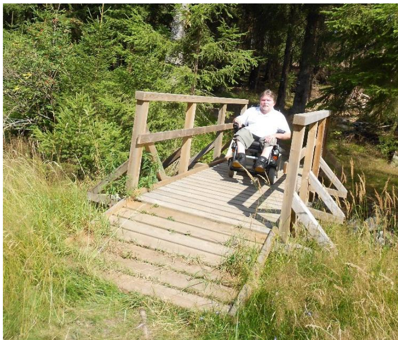
Lávka na přístupové cestě k leštině
