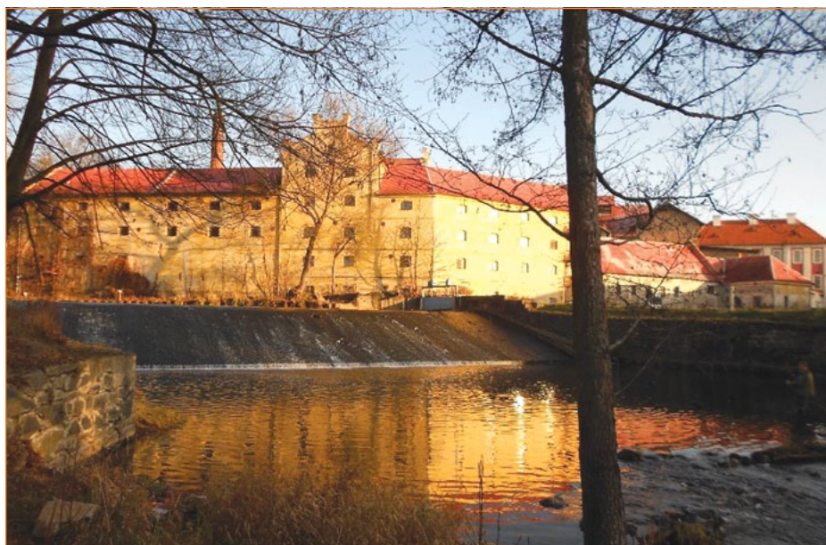
Plasy – řeka Střela pod klášterním komplexem – Bez vody se stavba zřítí...
