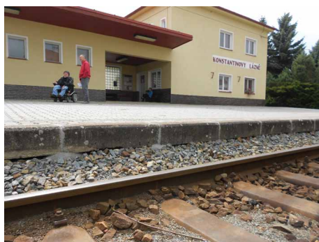
Foto 5 – Bezbariérová železniční stanice v obci Konstantinovy Lázně
